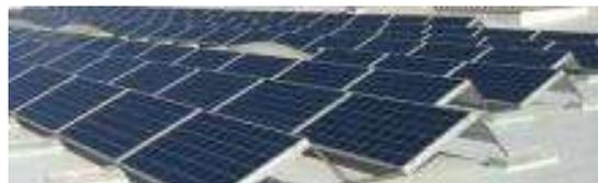
Installazione inclinata su tetto con zavorra
